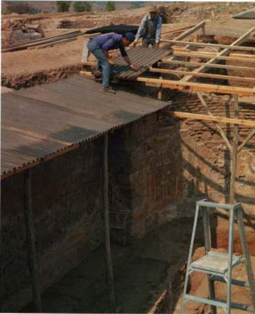
Figure 1: Temporary protective roof over excavations at Sardis, Turkey. Resim 1: Sardis kazı alanları üzerindeki geçici koruyucu çatı, Türkiye. Credit: Glenn Wharton
